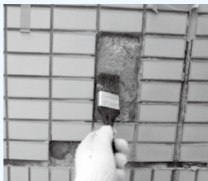
プライマー塗布（正面から）
