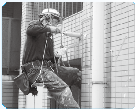
（写真4） タイル浮きの修繕<エポキシ樹脂注入>
