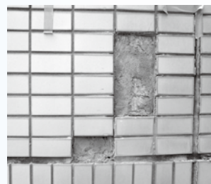
下地調整完了
