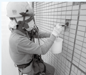
プライマー塗布
