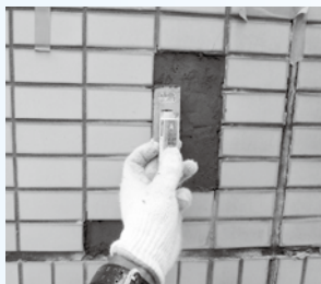
貼付モルタル塗布
