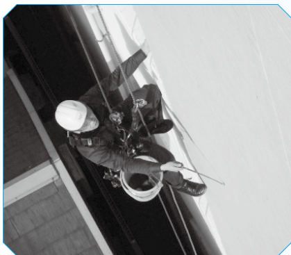
(写真1) 外壁調査<打診>
