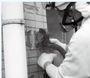
不良部品タイル剥がし
