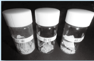
①流出環境が異なるエフロ3種を採取 A：タイル目地より流出（江東区）、 B：花崗岩パーナー仕上げの目地より 流出（新宿区）、C：コンクリート打ち 放し壁面より流出（横浜市）
