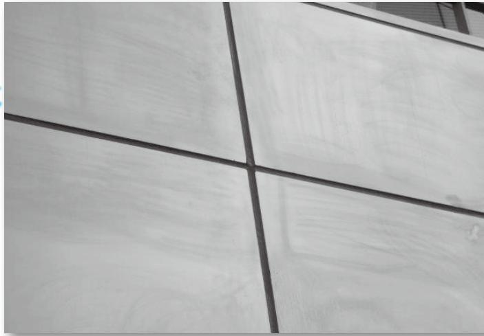
一見、CASE-1「アルミパネル洗浄時の拭き斑」の事例（7月号掲載）に似ているように見えるが、当該症状は単なる拭き斑ではない。粒度の大きいアルミナ系または炭化ケイ素系等の研磨材を使用したことによる発傷痕と推測される。
